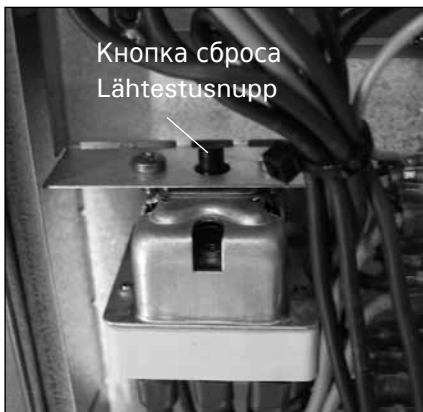
Рис. 3. Защита от перегрева Joonis 3. Ülekuumenemiskaitse
